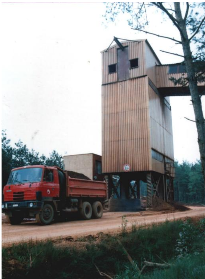
115. ábra. Gépkocsitöltő állomás
