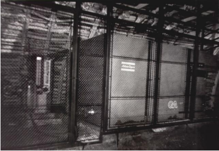
110. ábra. Földalatti telepítésű csavarkompresszor állomás
