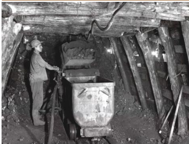
52. ábra Fa biztosítási fejtési kamra. (ritka oldal, sűrű főtebeveléssel) MAM
