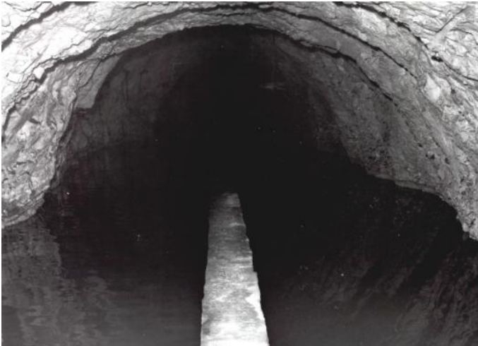
104. ábra Rákhegy II. Vízbánya. Ivóvíz gyűjtése és ülepítése. (MAM)
