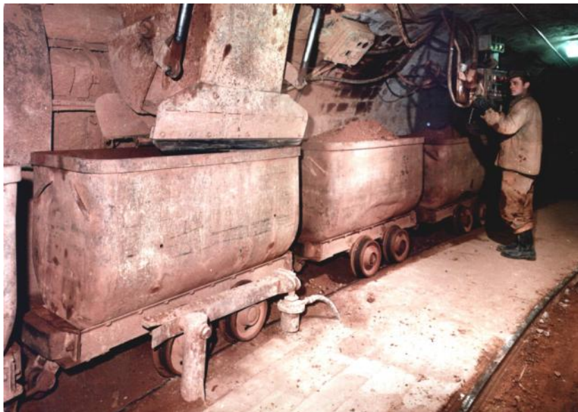
100. ábra József III. +30 m szinti csilletöltő és szalagvezérlő állomás (MAM)
